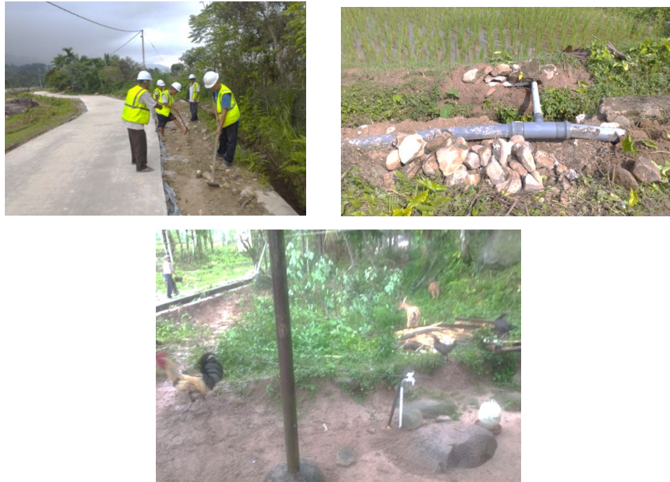
Gambar 3.A.5.13 Penambahan Jaringan Pipa Transmisi Air Minum ke Rumah Masyarakat Penerima
